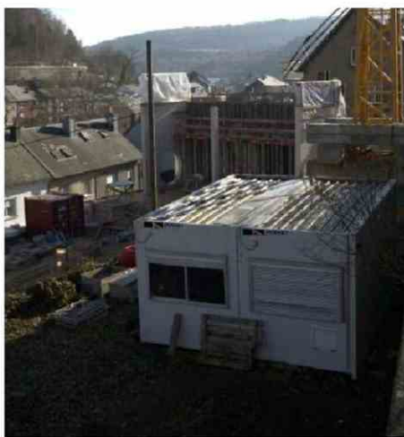
Das im Bau befindliche Nebengebäude des Albert-Hames-Hauses in der Rümelinger rue de la Bruyère Foto: Editpress/Lucien Montebrusco
