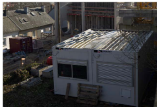
Das im Bau befindliche Nebengebäude des Albert-Hames-Hauses in der Rümelingers rue de la Bruyère
